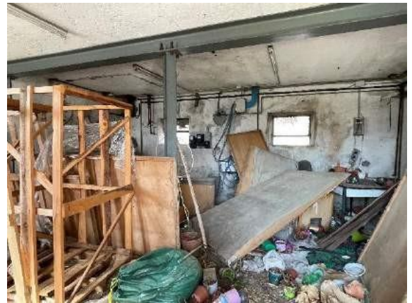
Vista interna del ripostiglio al PT
