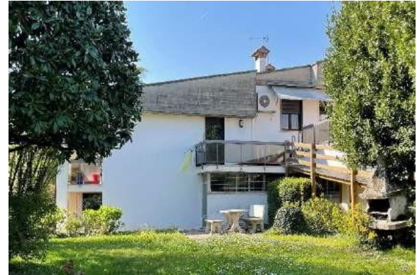
Vista dell'abitazione lato est
