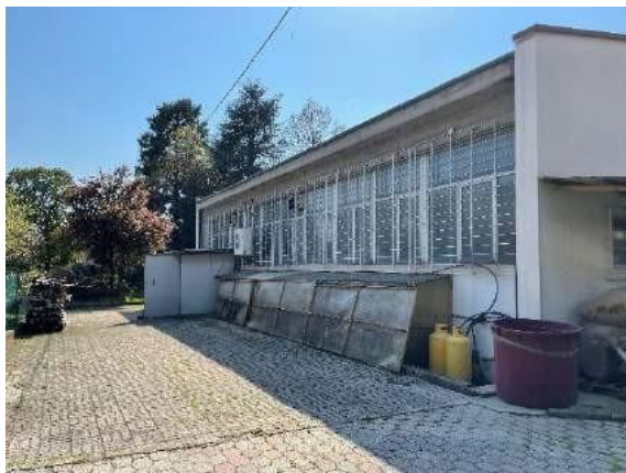
Vista dell'ingresso del laboratorio lato est
