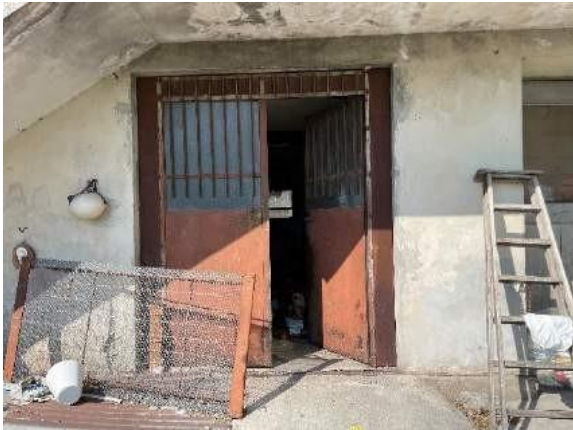
Vista dell'ingresso al ripostiglio
