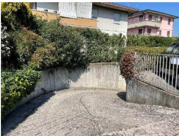
Vista della rampa di ingresso all'autorimessa
