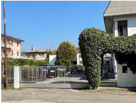
Vista dell'ingresso pedonale e carrabile
