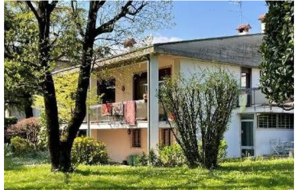
Vista dell'abitazione lato sud-est
